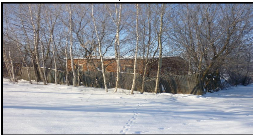
Насосная станция в п. Новольвовск
